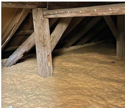
Bilde 30. Etterisolering av loft
