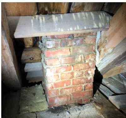
Bilde 29. Pipeløp avkortet
