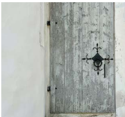
Bilde 24. Malingsslitasje på dør
