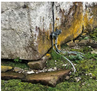
Bilde 4. Bakkenivå over fundament
