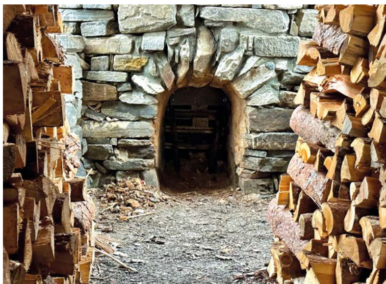
Nybygget kalkovn på Moster for brenning av tradisjonskalk
