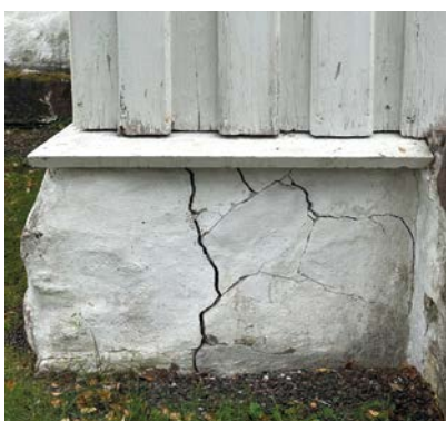
Bilde 2. Setningsskader
