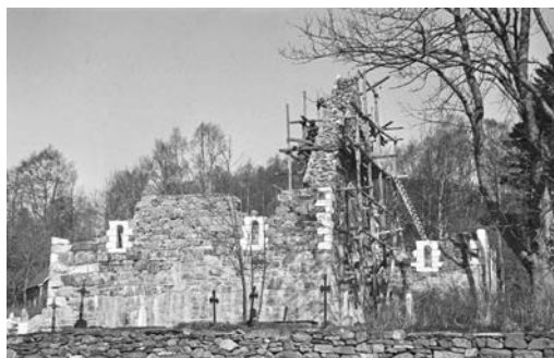
St. Jetmund kirke slik kirken fremsto under gjenoppbyggingen på 1950-tallet etter at kirken ble revet ned til grunnmuren i 1863. Det er også vedlikeholdsutfordringer knyttet til gjenoppbyggingen av denne kirken. Kirken sto på nytt ferdig i 1957. Bilde Riksantikvaren.
