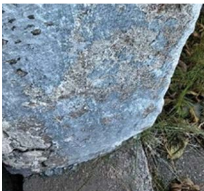
Bilde 41. Tett maling over mørtel
