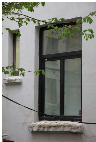
Foto, høyre: SINTEF Byggforsk
