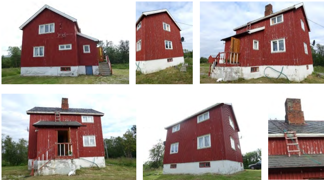
Huset i Børselv. Øverst til venstre gavlfot mot nord, videre gavlfot mot sør, bislag med inngang mot vest, fasade mot sør. Bislag med takpapp, hovedbygg med skifer, pipe i tegl.
