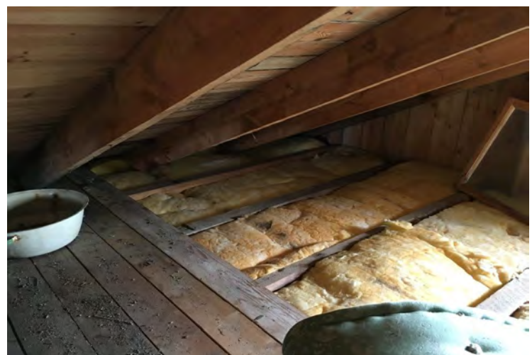
Fra gangen i første etasje kan man gå opp trappen til loftet med de fire soverommene. Her er det en luke opp til kryploftet slik at man kan få inspisert isolasjon og skorstein. Det fins også ett vindu i hver gavl for utvendig inspeksjon.
