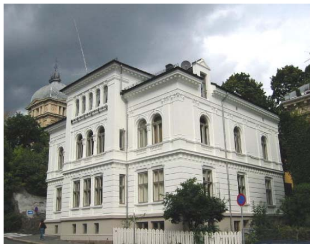
Murvilla fra 1884 i Homansbyen, Oslo. Teglstensveggen er pusset og malt og har nydelig dekor. Dette gjør det vanskelig å etterisolere husets utside.
