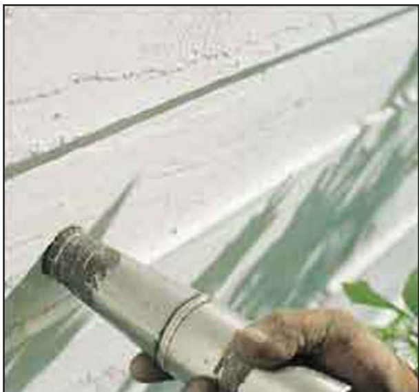
Innblåsing av isolasjon i vegg. (Foto: Enøkssentrene)
