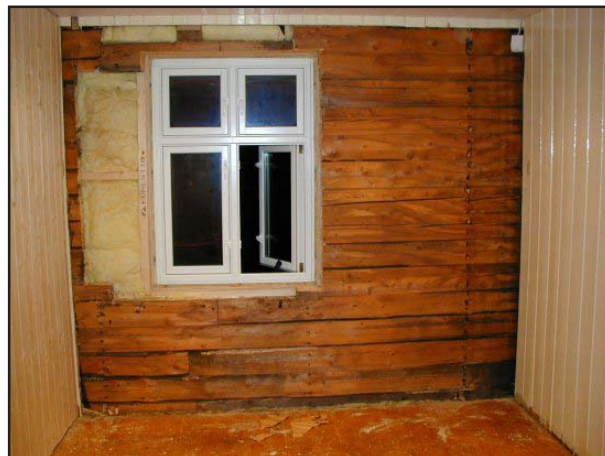
Hvis man likevel må skifte innerkledningen, kan man samtidig inspisere vegg i forhold til råte og angrep av parasitter. (Foto: Husbyggeren Norge)
