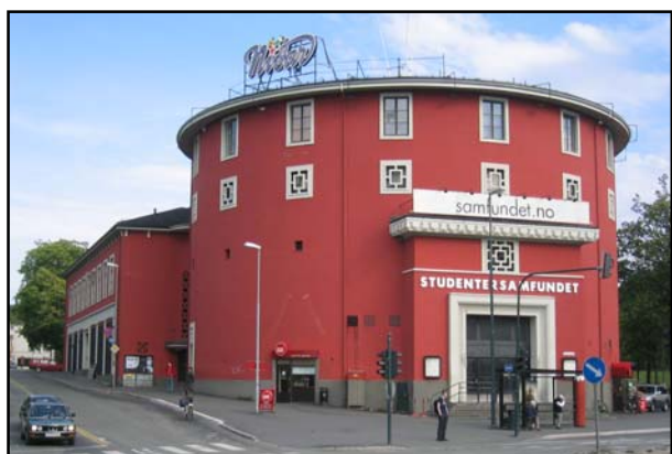
Studentersamfundet er et av de første rene betongbygg i Trondheim. Materialet muliggjorde den spesielle planløsningen, og bygget sies å ha over seksti forskjellige nivåer. (Foto: K. Hermstad)
