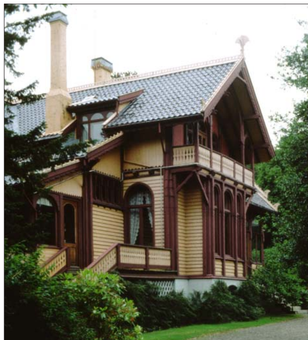
Villa Breidablikk, Stavanger. Bolighus fra siste del av 1800-tallet har ofte rikt dekorerte fasader med profilert panel, balkonger, altaner og maskinhøvlet listverk. Husene er ofte oppført i reisverkskonstruksjon. (Foto: D.Nilsen)
