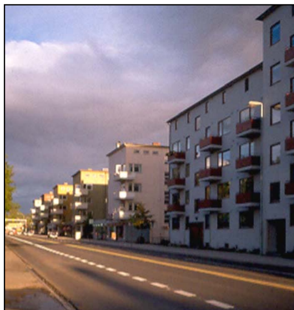
Voldsminde i Trondheim er et av de første eksemplene på sosial boligbygging med betong. 295 leiligheter er organisert i lavblokker med bærekonstruksjon og dekker i betong. (Foto: W. Knudsen)
