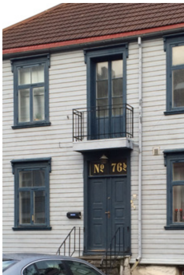
Ny balkong og balkongdør etablert etter 1975.
