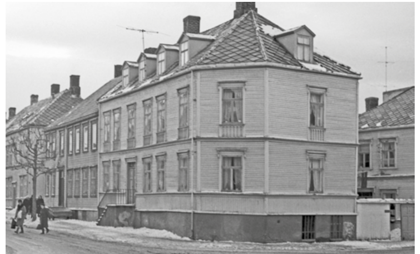
Nedre Møllenberg gate 1-3 1970. Trondheim byarkiv, byantikvarens negativsamling.
