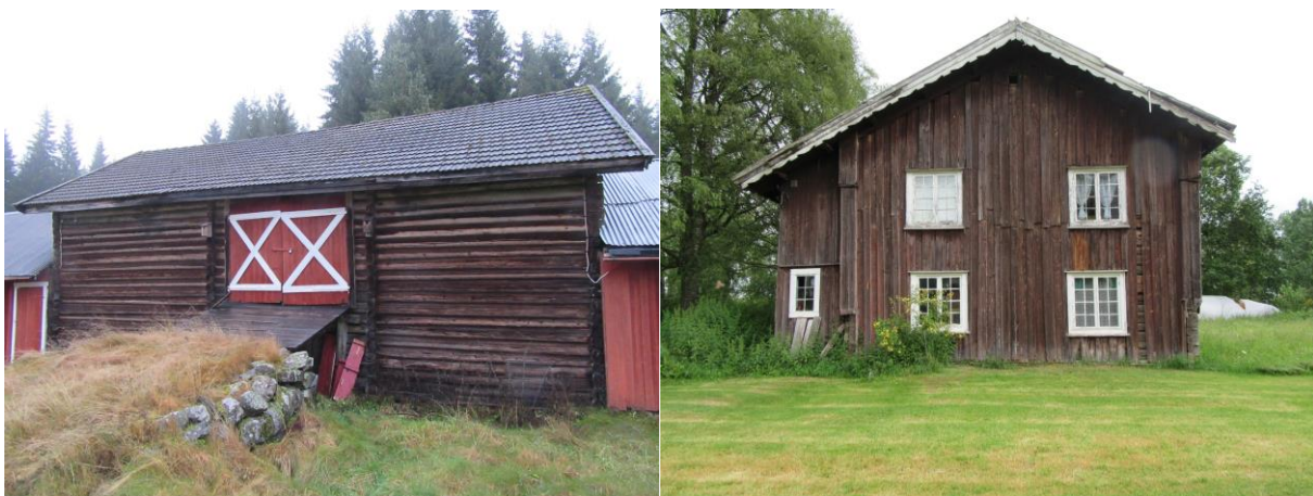
Tømmerlåven på Søndre Rakeie. På Skogen var tømmerlåvene lengre i bruk enn nede i bygda. derfor er det en større konsentrasjon av tømmerlåver øst på Skogen i Nes. Bildet til høyre viser gavlen på svalgangsbygningen på Ullershov nordre.
