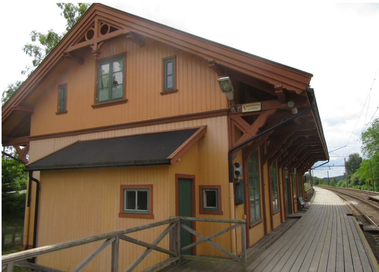
Haga stasjon er i likhet med Årnes og Seterstøa stasjon tegnet av arkitektene Schrimmer og von Hanno.
