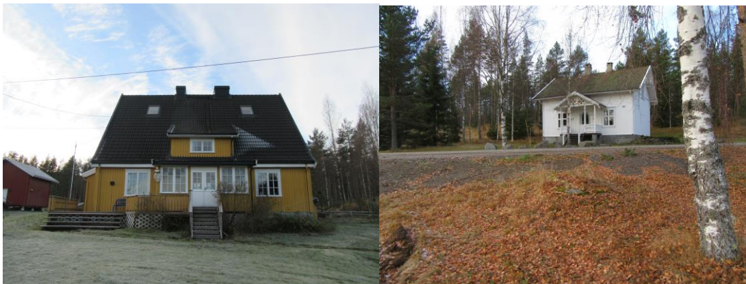
Administrasjonsboligen til Stangeskovene til venstre og aksjonærvillaen til høyre.
