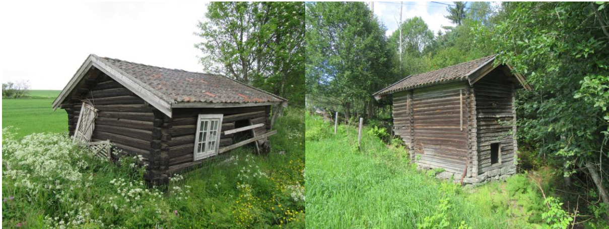
Til venstre smia på Nedre Valstad under istandsetting. Kjona i Fallet ble satt i stand for få år siden og er i god stand.
