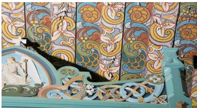
Interiør i Eid kirke. Himlingen med originale dekorasjoner utført av Lars Kinsarvik i 1915, var skadet. Den ble i 2014 rekonstruert på nytt panel for å kunne bevare originalen bak, se prinsippskisse. Foto: Birger Lindstad, Riksantikvaren. Tegning: Jørgen Solstad (NIKU-rapport 23/2008).
