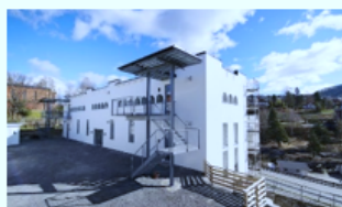
Kabelhuset, Notodden, er en transformatorstasjon fra 1916. Den gamle koblingsstasjonen for kraftoverføring
