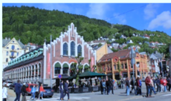
Kjøttbasaren, Bergen, er oppført 1874–76 i nyromansk stil. Bygningen har blitt ombygd og modernisert i
