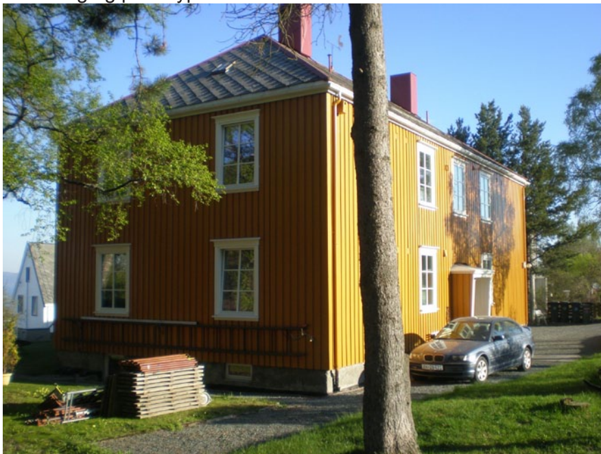
Kompakt knapp bygningskropp med profilert og høvlet tømmermannspanel. Vertikale vinduer bunnhengslet med løssprosser, som endrer vindusformatet i de 6 rutene med fin og enkel belistning.
