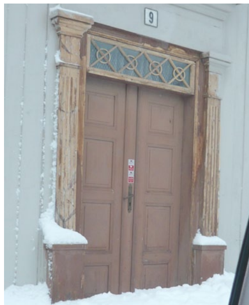
Solbugården: Staselig, verdig, rikt detaljert bevaringsverdig inngangsdør
