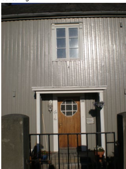
Opprinnelig vindusformat med sidehengslet 2-delt vindu med faste sprosser og 3 ruter, tidsriktig forfinet belistning, enkelt fint inngangsparti og inngangsdør.
