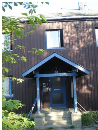
Rehabilitert og etterisolert. Nyutvikling som blir for flat og uten relieff med nytt vindusformat uten belistning og forenklet panel. Inngangen er fint og tydelig markert.
