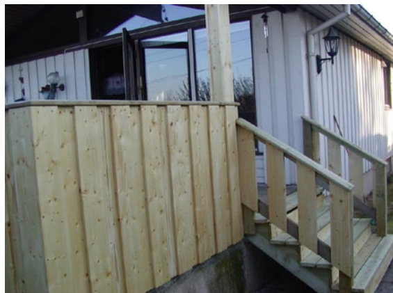
Ikke samkjørt rekkverk på veranda og trapp
