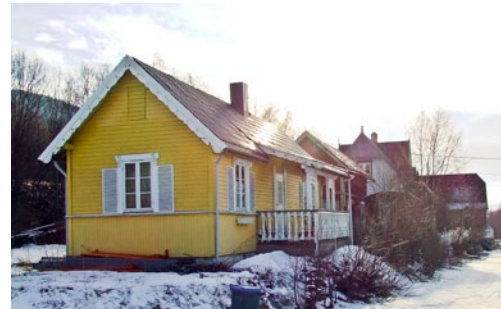
Ca. 1910- Thamshavn Ferdighus som utstillingshus på rekke
