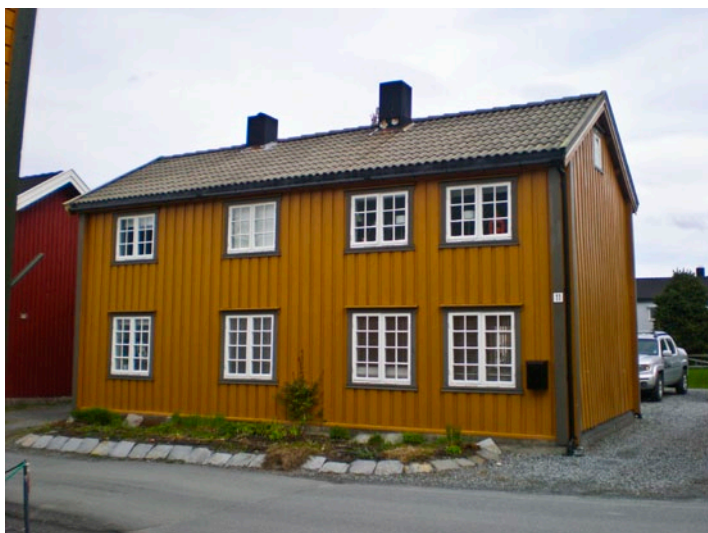
Bygningens form og uttrykk er enkelt og knapt og det er sammenheng mellom bygningens uttrykk og detaljer ved takutstikk og vindusbelistning.
