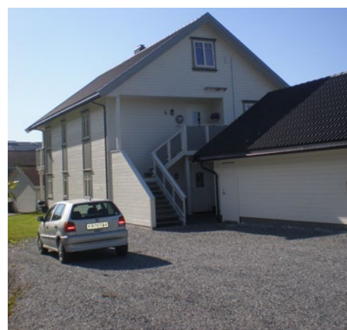
Evjen: Her er det prioritert parkeringsplass for bilen ved inngangen.
