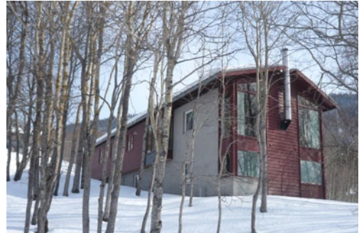
Ca. 1985- Hovsbakkan 1-2 etasjes spesielt bolighus utradisjonelt tilpasset terrenget, på tvers av kotene-tradisjonell takform med vellykket utradisjonell detaljering og materialbruk
