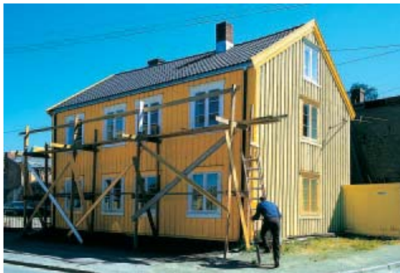
Bygning under restaurering på Baklandet i Trondheim.
