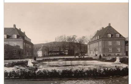
Damplassen under bygging
