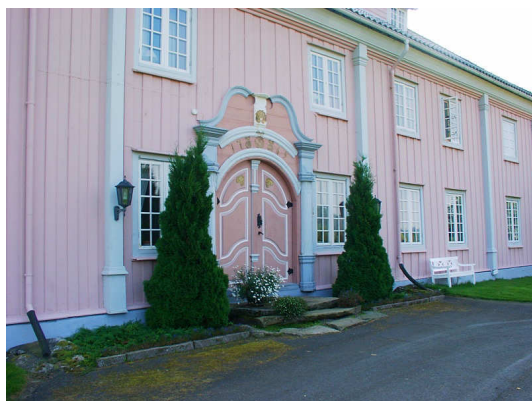
Fig. 08 Grindergård, 1760-årene Bygningen er kompakt og symmetrisk, med stående novkasser utformet som søyler på veggen. Merk de svungne linjene i døroverstykket, samt de buede dørspilene.
