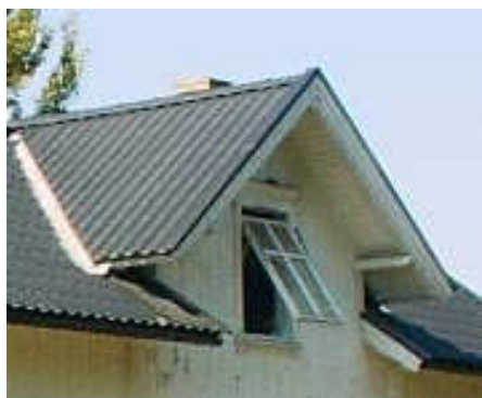
Fig. 52 Uheldig vindusløsning
