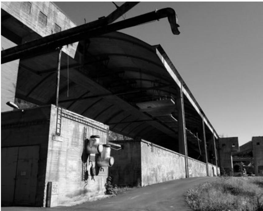
Det er likevel først og fremst Skalltaket som vitnar om mogelegheitene betongen hadde å by på. Skalltak er eigentlig eit faguttrykk for boga tak støypte av et tynt lag armert betong. Forma gjer det mogeleg for eit stort tak å vera sjølvberande mellom støttepunktta. Skalltaket som blei bygd på 50-tallet er ikkje berre eit viktig landemerke i Odda, men også eit døme på eineståande ingeniørkunst.
