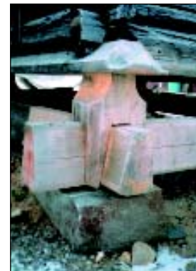
Stabbe, grime og holdstein på stolpehus.
