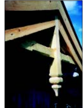
Utskifting av gavlavslutning.
