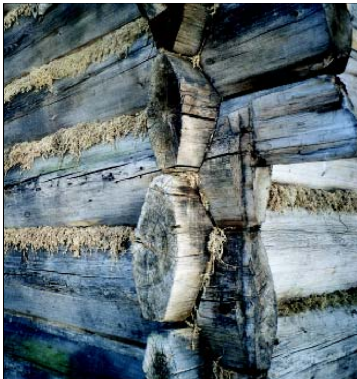
Heimigard Berg i Valle. Eldre laftebygg under restaurering. Husmose som tetting mellom stokkene.
