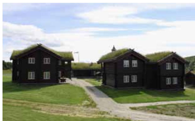
Gården Orkelbogen på Kvikneskogen ble i 2008 bygget opp igjen etter en brann på slutten av 1800-tallet. Prosjektet, som er tegnet av Arkitektene Berg og Østvang, skulle framstå som en gård fra 1800-tallet, men med fasiliteter, komfort og miljøtenkning som tilfredsstiller dagens krav.
