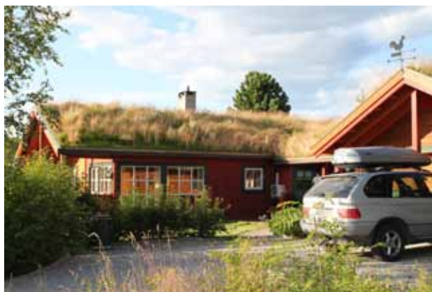
Denne eneboligen har en material- og fargebruk som kler omgivelsene. Husets solside er kledd i stående panel og malt rød, mens skyggesiden er kledd i okerfarget liggende panel.
