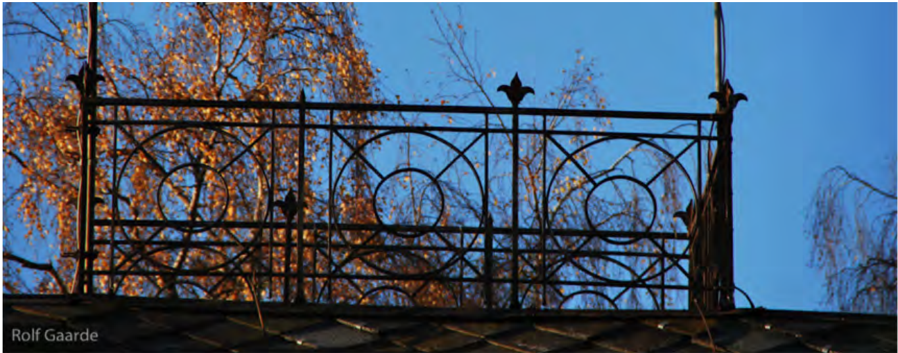
Rekkverk fra takterrasse i Kirkegata 32.
