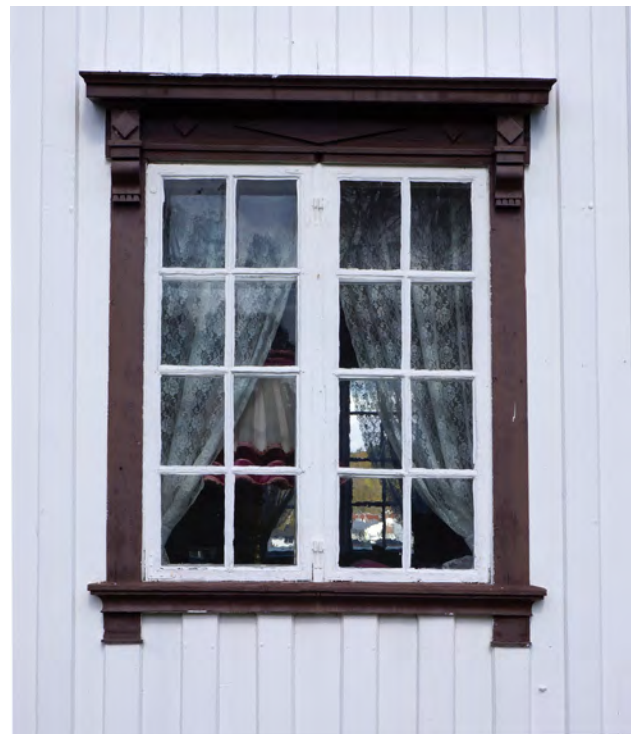
Vindu på Brusve gård.
