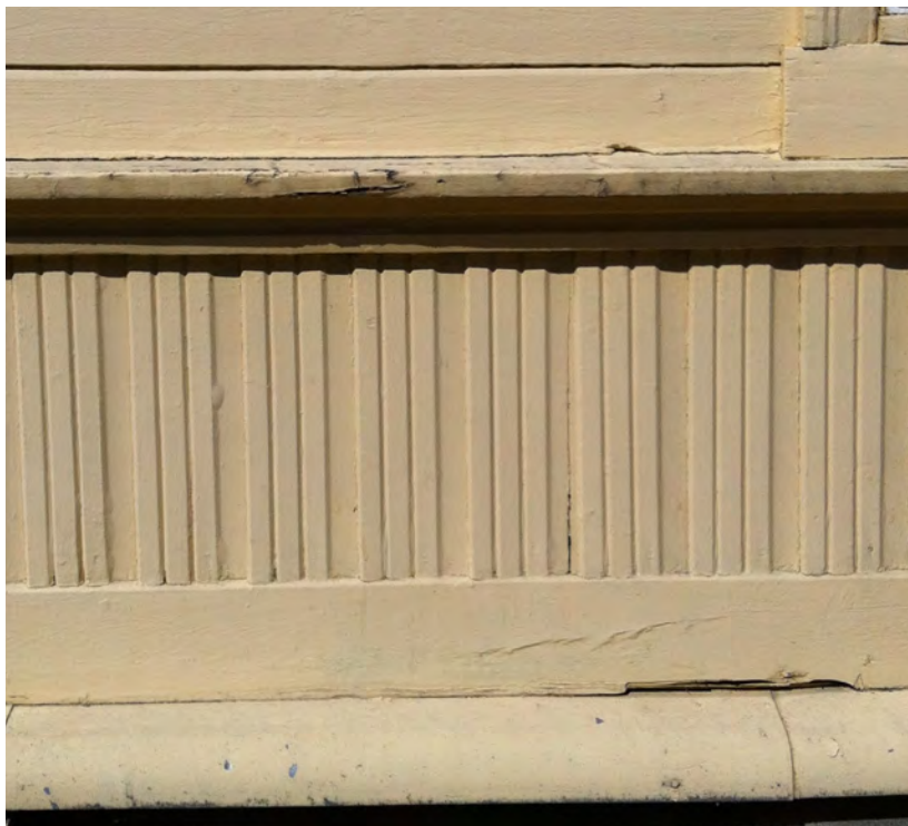
Håkon Den Godes gate 39. Pløyd panel i bånd, dobbelfalset panel på veggen forøvrig.
