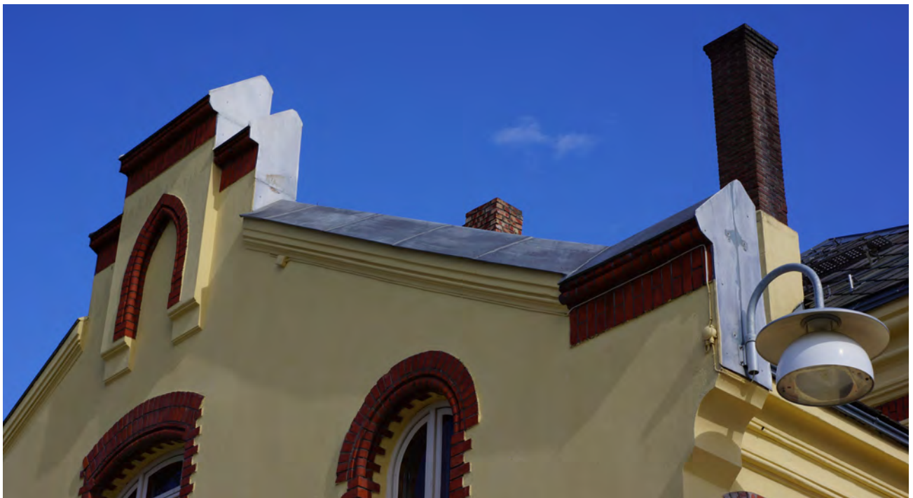
Beslag på gavler på Levanger stasjon.
