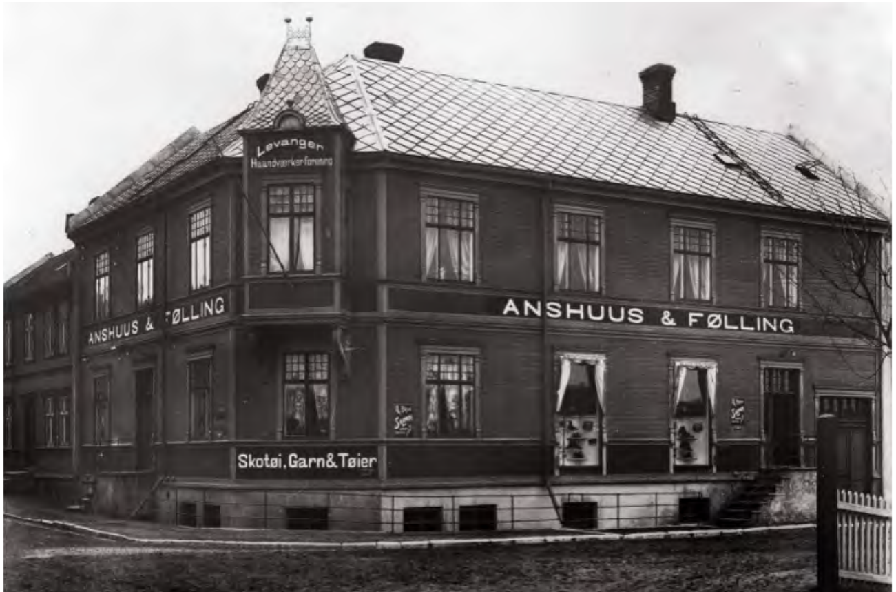
Enkelt rekkverk foran lysgrav. Jernbanegata 17 A
