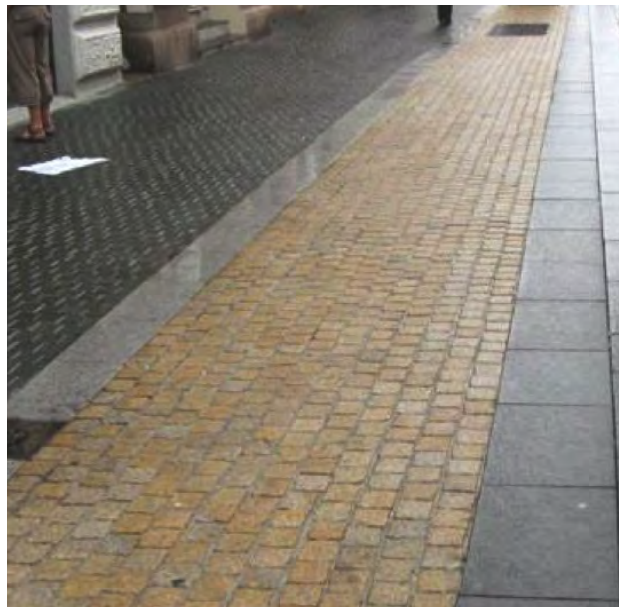
Variasjon av fortausbelegg gir beskjed om forskjellig funksjon, og letter orienteringsmulighetene.
