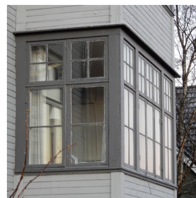
Stavnemovegen 7 har viktige aldersverdier inntakt i glassverandaene. Med godt vedlikehold kan vinduene stå i 100 år til.
