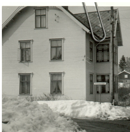
Ved vindusutskifting på 70-tallet la man ikke alltid vekt på å beholde samme inndeling som tidligere. Stavnemovegen 11 (1977)
