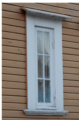
Stavnemovegen 5 har noen opprinnelige vinduer med omramming inntakt som må tas vare på.
