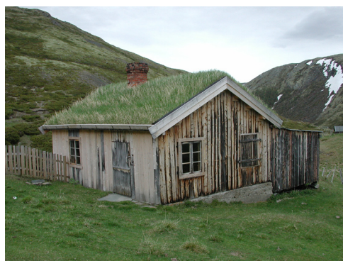
Ysteribygningen fotografert sommeren 2005 - etter reparasjonen. Alle takåsene og taktroa ble skiftet ut og huset har fått nytt torvtak. Deler av veggkledningen ble reparert. Vinduene - de originale - ble restaurert.
