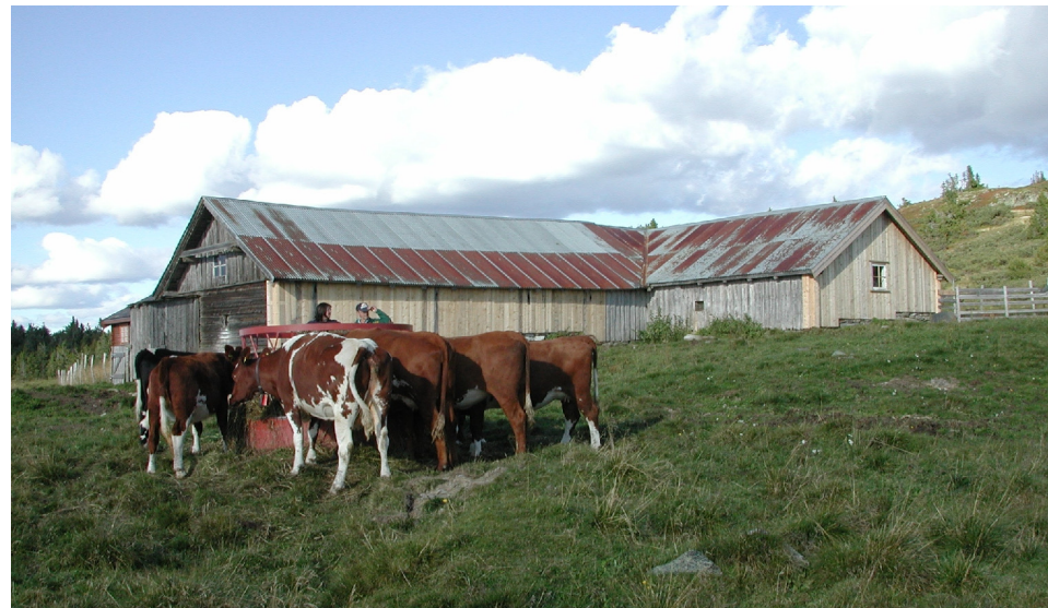
Fjøset på Lindviksetra i Ringebu er reparert og sikret med panel på de veggene som var for dårlige. Bordene blir grå av seg selv.
