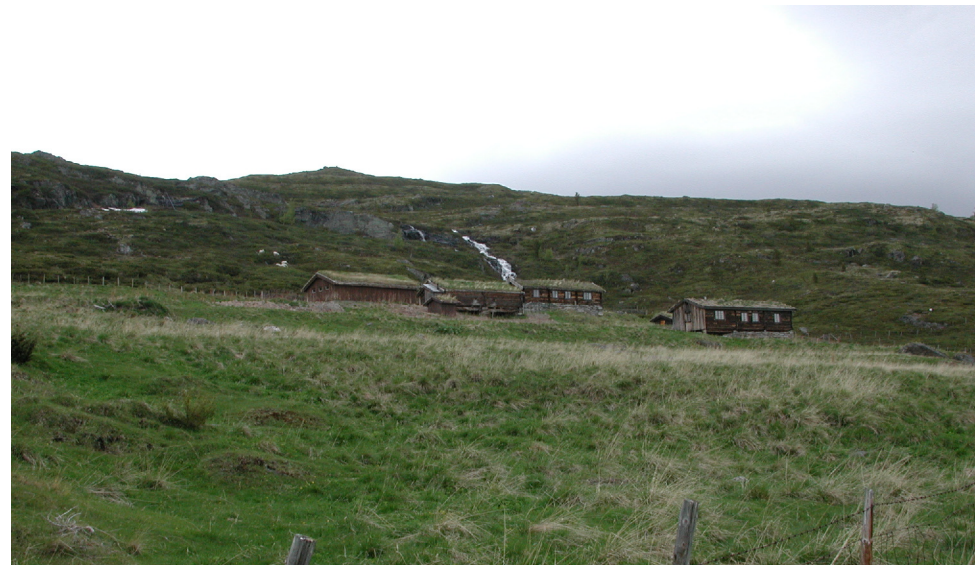
Vigerustsætre sommeren 2005. Nå er det torv på alle takene. Det er selvsagt veldig greit, der en kan påvise at taket tidligere har vært tekket med torv. Bygningen er sikret for mange ti-år og den gode seterkarakteren fastholdes i bygningene.
