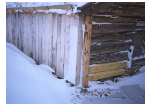
Tiltaket sto ferdig høsten 1999.
