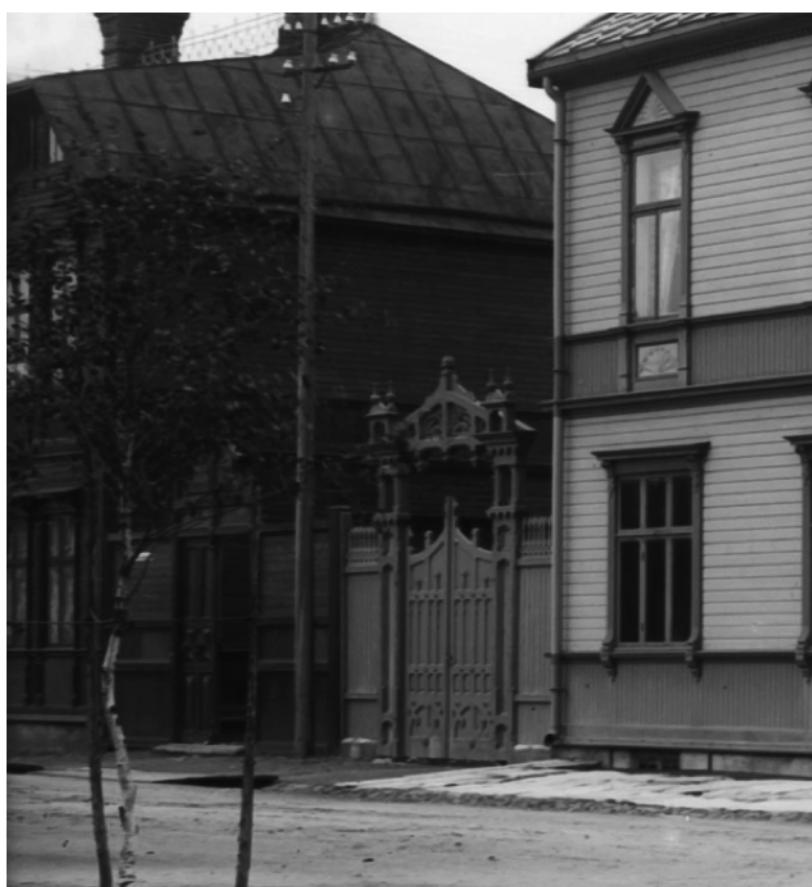
Annet bilde av Kirkegata 43 som viser detalj av gjerder og port inn til bakgårdene til Kirkegata 43 og Sjøgata 14 A.
