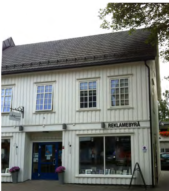
I Kirkegata 52 er det en kombinasjon med bokstaver direkte på kledningen og faneskilt.
