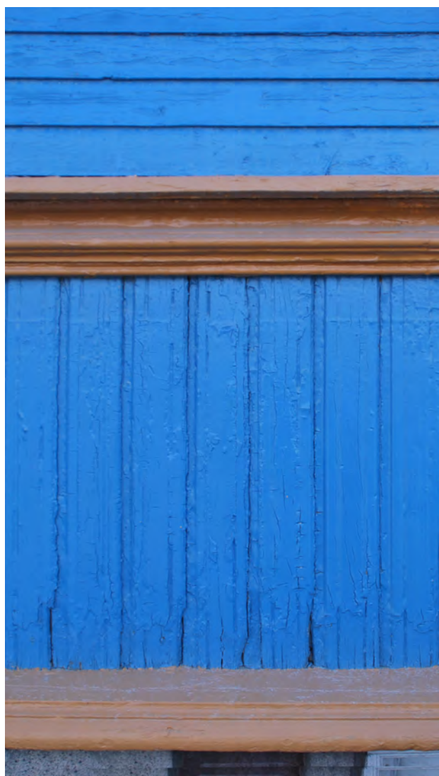
Sjøgata 10. Dobbelfalst panel på vegg i kombinasjon med pløyd panel i bånd.
