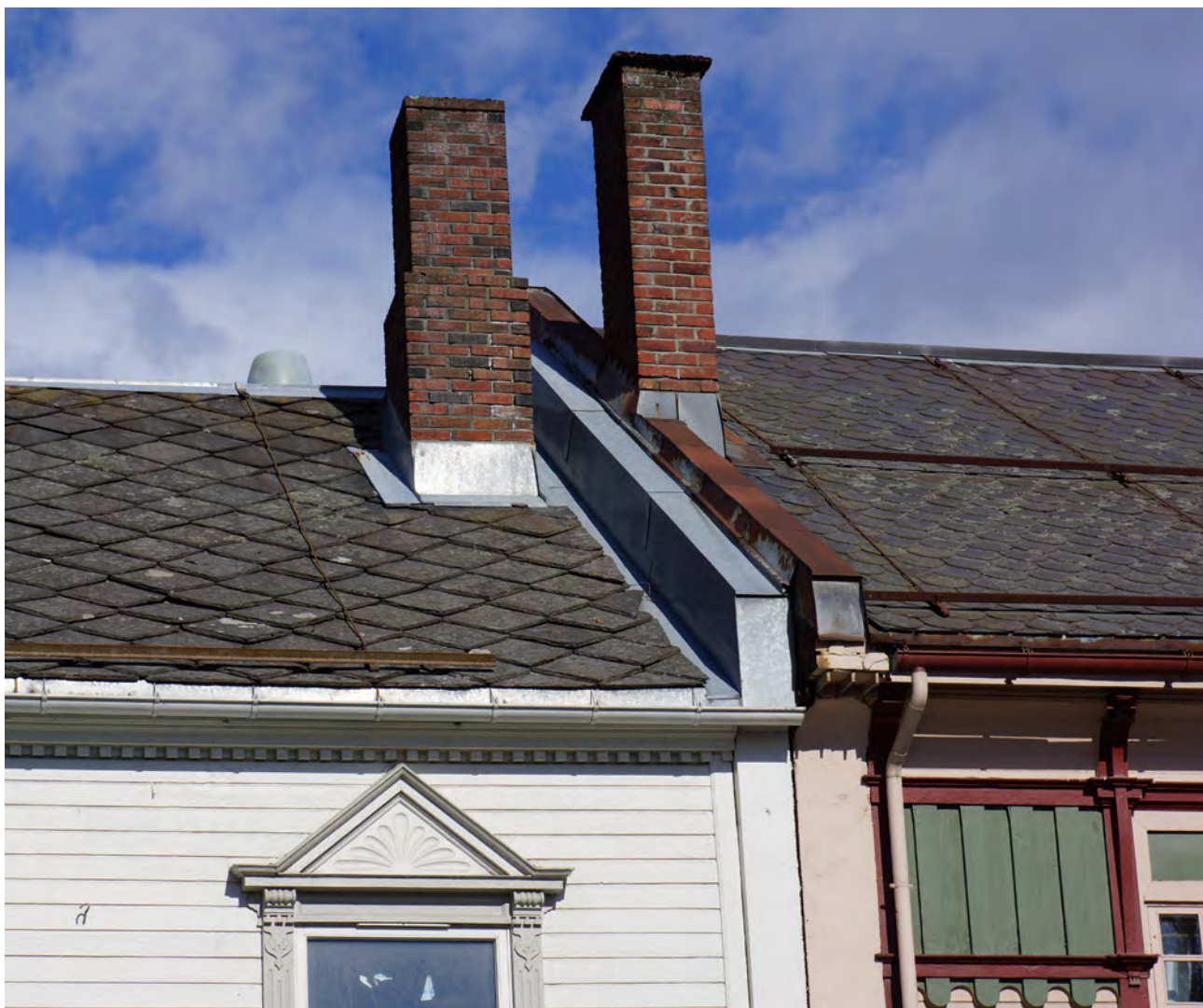
Møtet mellom husene i Kirkegata 43 og 45 A.
