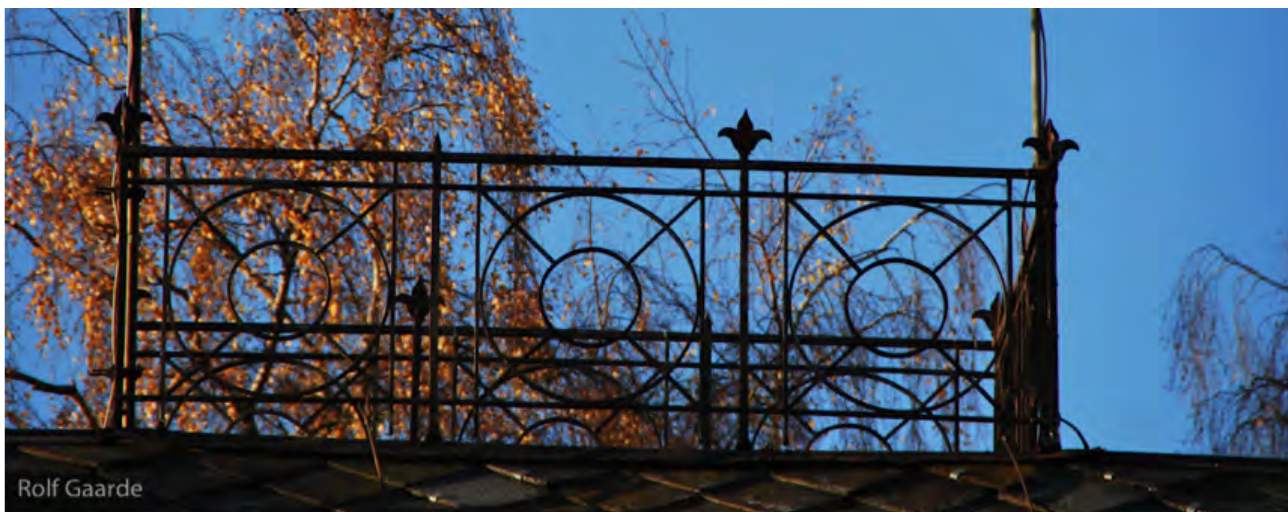
Rekkverk fra takterrasse i Kirkegata 32.
