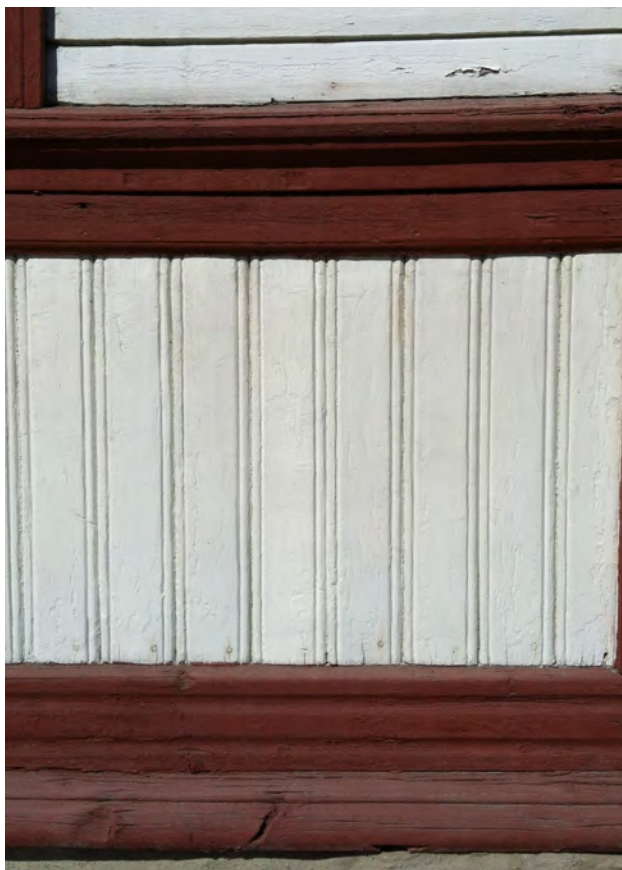
Kirkegata 65, Sveitserpanel, (pløyd panel) i bånd, dobbelfalset panel på veggen forøvrig
