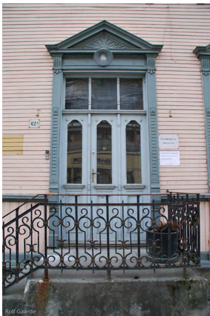
Rekkverk i smjern på trapp til Sjøgata 42 A.
