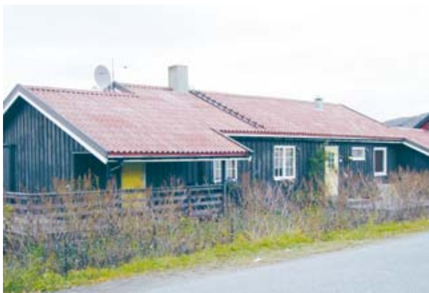
Det er mulig å kjenne igjen hva som er hovedbygg og tilbygg. Det er brukt samme materialer til tak og vegger.
