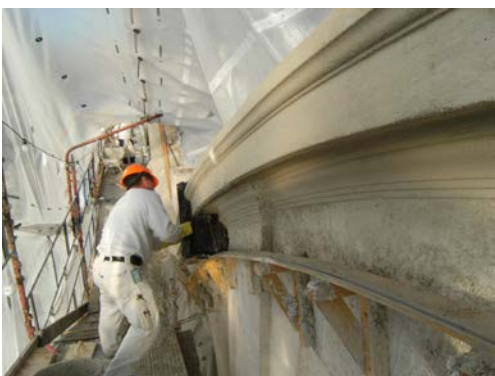
Håndverkere driver opptrekking av profiler på det gamle trelastlageret i Schweigaards gate 28
