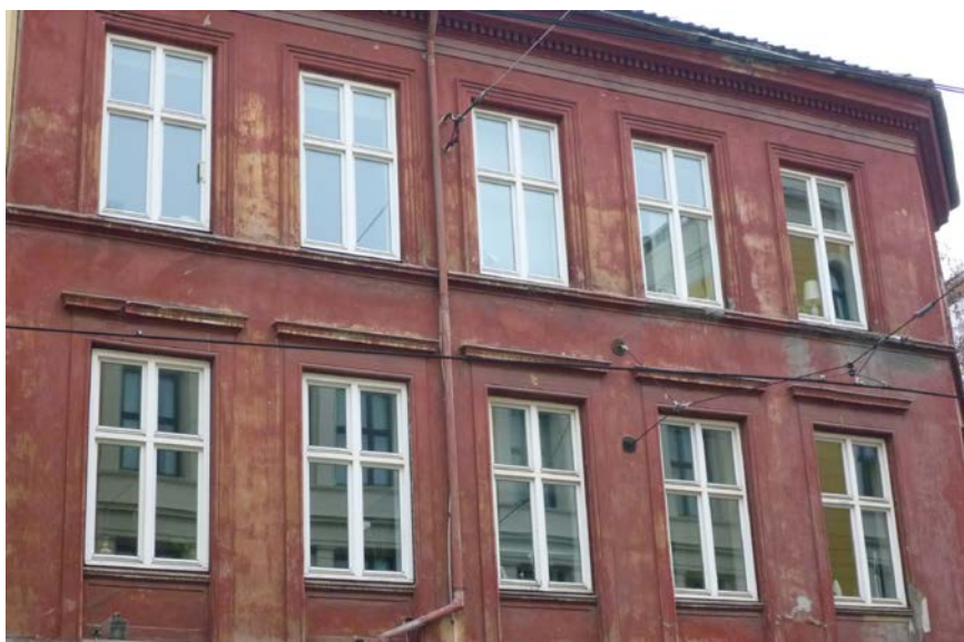
En kalkmalt fasade etter mange tiår uten vedlikehold. Malingen brytes sakte ned, men flasser ikke av, og beholder mange av sine tekniske og estetiske kvaliteter.
