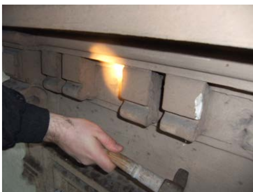
Fortanningsornamentikken undersøkes med en murhammer. Er den løs? Er det gips? Grundige forundersøkelser er avgjørende for et godt sluttresultat.
