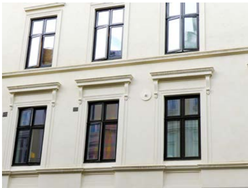
Helgesens gate 12 og 14. De to bygårdene er tilbakeført til original fargesetting - mørke vinduer og lyse fasader. Fasadene er kalket. Bak utallige malingslag ble de gamle fasadebokstavene fra Samvirkelaget funnet. Disse er nå malt opp igjen.
