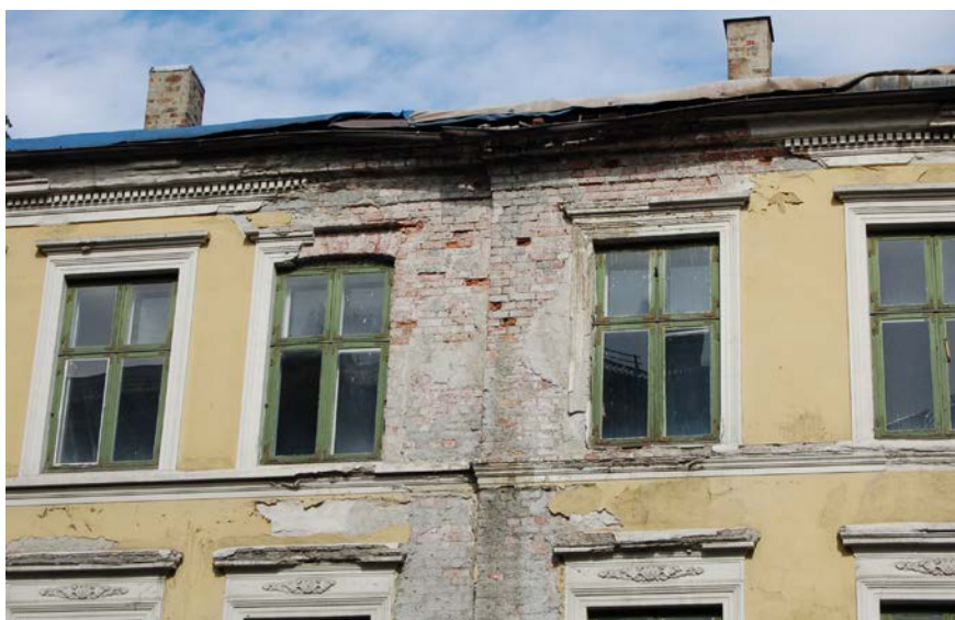
Takskade og manglende nedløpsrør har ikke bare gitt store skader på pussfasaden. Nesten alt treverk på innsiden måtte skiftes ut p.g.a. ekte hussopp.
