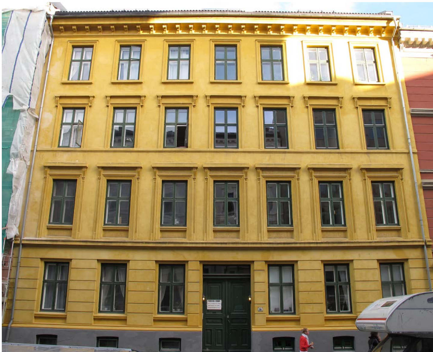
Hansteens gate 18. Fasaden ble kalket på midten av 1990-tallet og står like fint etter nesten tyve år.
