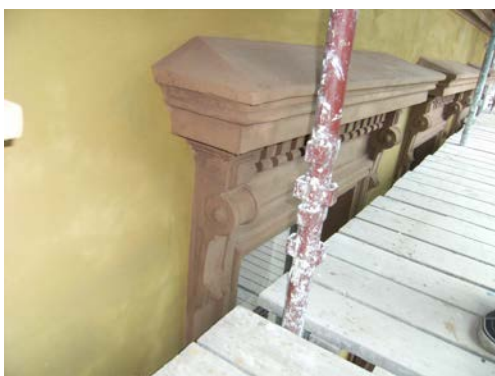
Antikvarisk rehabilitering, Paulus plass 2. Presise avslutninger og hjørner er viktig.
