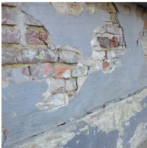
Skader etter bruk av for sterk puss. Det oppstår sprekker, og pussen har delvis dratt med seg det ytterste laget av teglsteinen under.
