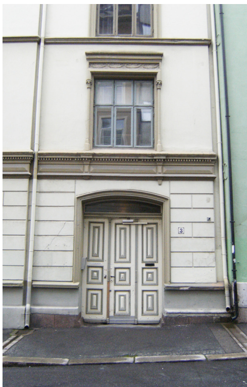
Peder Claussøns gate 3, oppført 1873, har uoriginal fargesetting.
