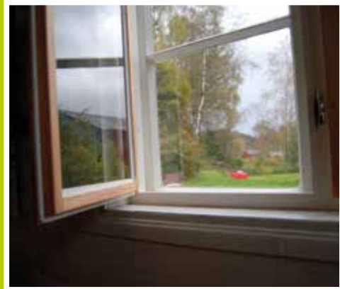
Varevindu i egen ramme innsatt i vindu
