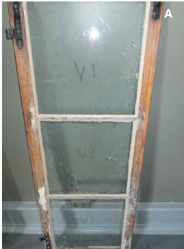
A: Ferdig kittet vindu med nummererte glass satt på plass. B & C: Fjerning av kitt med varmelampe
