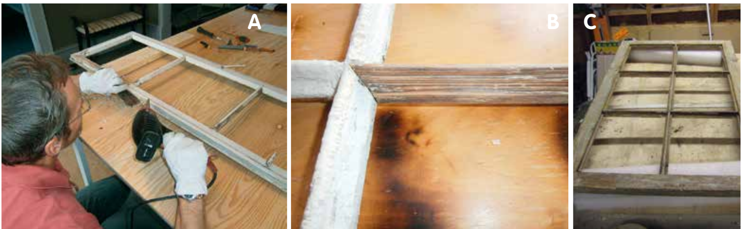
A: Fjerning av maling med varmluftpistol. B: Tykke malingslag skjuler forseggjorte profiler. C: Ferdig rengjort rammme
