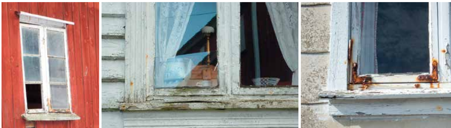
Originale vinduer preget av manglende vedlikehold
