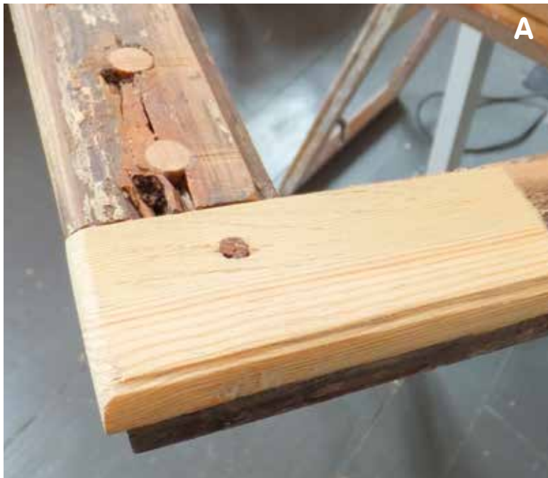
A: Innfelling av nytt hjørne. Utskifting av treverk begrenset til dybden på overfalsen. Nye treplugger til nytt feste for skruer B: Innfelling av nytt feste for skruer
