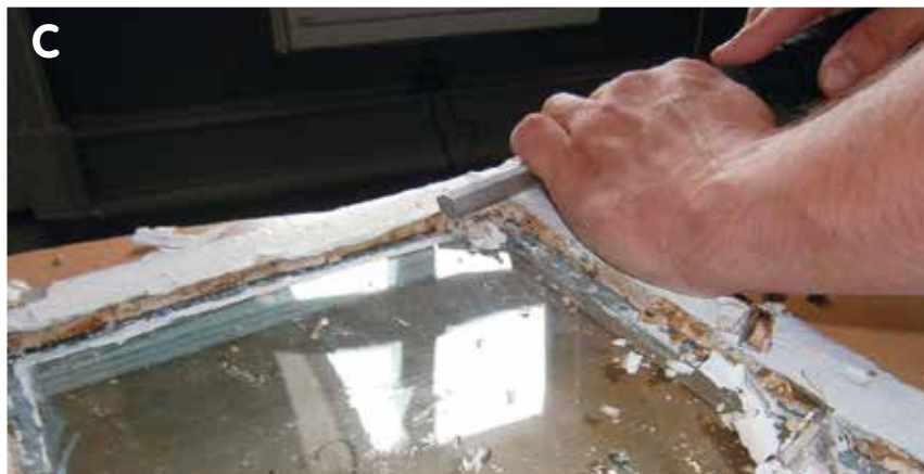
A: Ferdig kittet vindu med nummererte glass satt på plass. B & C: Fjerning av kitt med varmelampe
