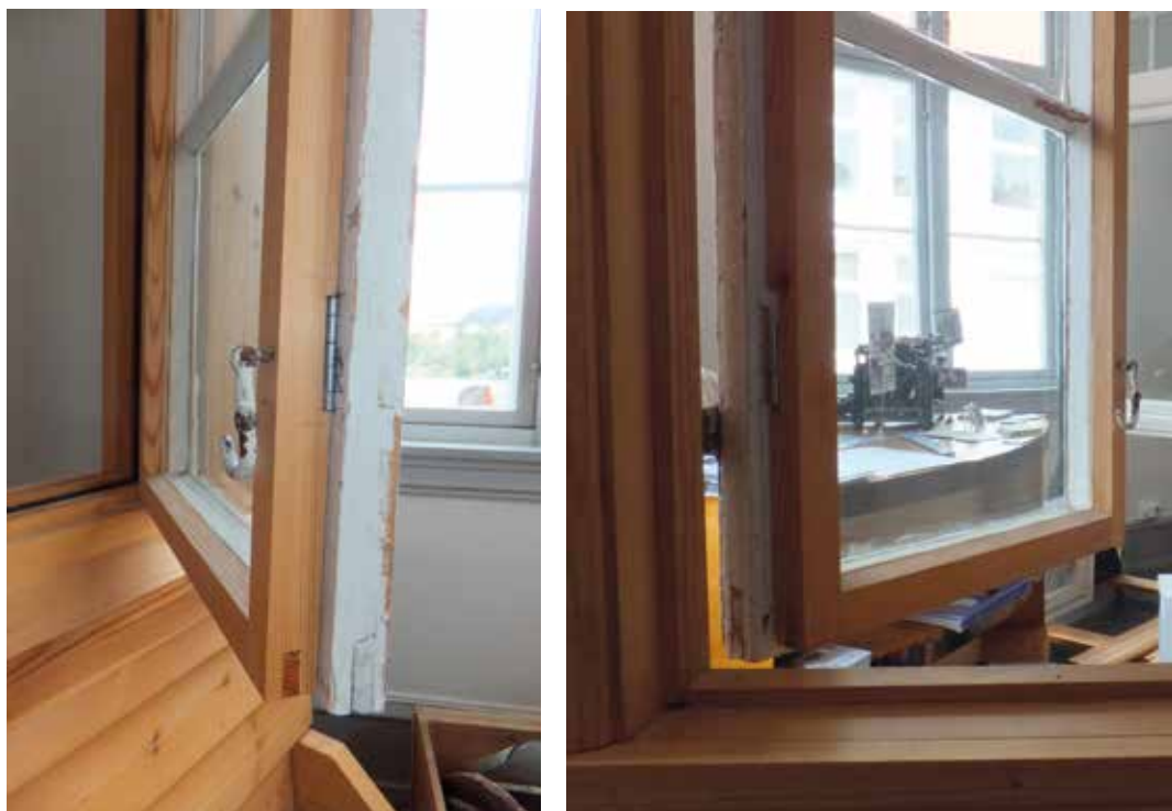
Ny ramme koblet til eksisterende ramme sett utenfra og innenfra. Anslagslist i karm. Fotografi av utstillingsmodell
