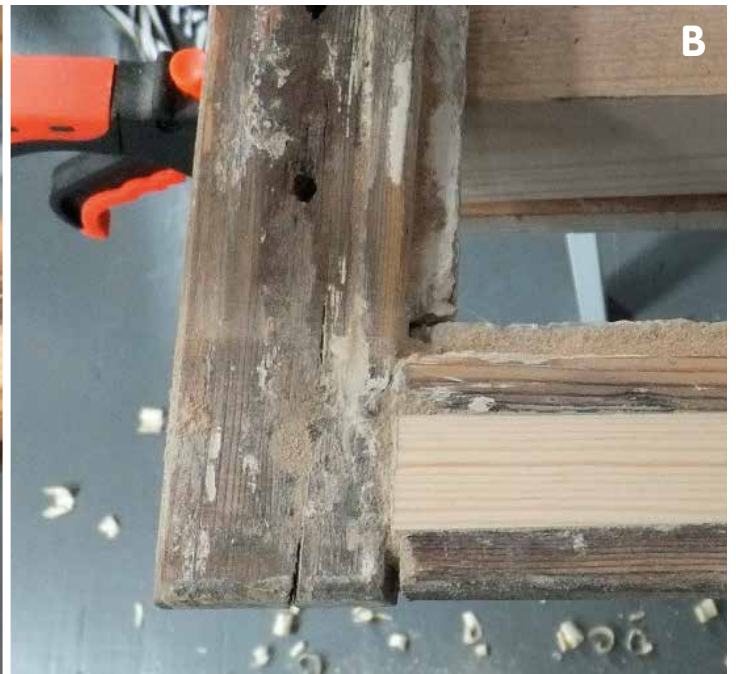
A: Innfelling av nytt hjørne. Utskifting av treverk begrenset til dybden på overfalsen. Nye treplugger til nytt feste for skruer B: Innfelling av nytt feste for skruer
